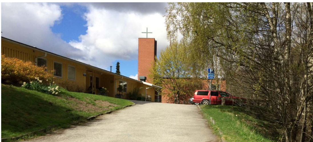
Bild på den befintliga förskolans framsida med Buråskyrkan i bakgrunden (Stadsbyggnadskontoret).
